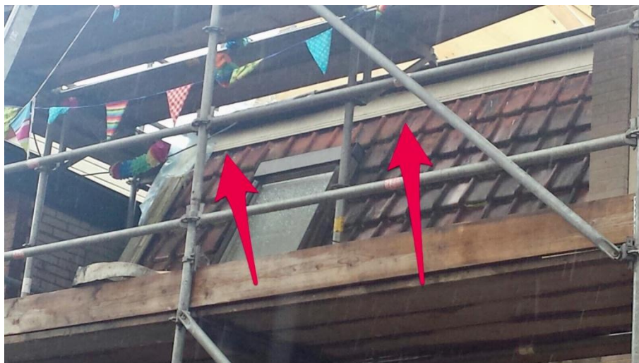
Figuur 2: Dakrenovatie in het broedseizoen 2017 in de Verhoevenstraat (foto: Hans van Paddenburgh)
