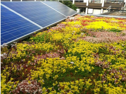
Voorbeeld van een groen sedum dak met zonnepanelen (foto: zonenco.nl ).
